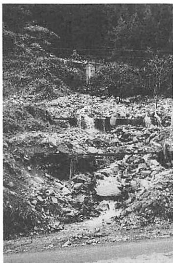
鉄砲水で切断された線路
