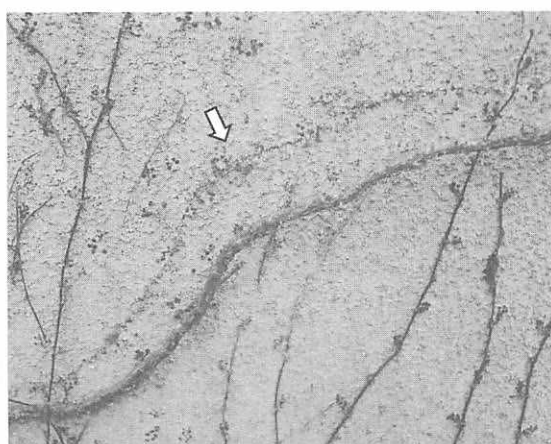
ツタの根の有機酸によって溶解変色したコンクリート壁面の様子（矢印）
