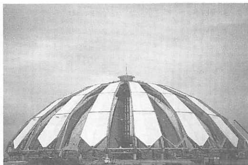
直径140mのもくもくドーム。工事中の風景
