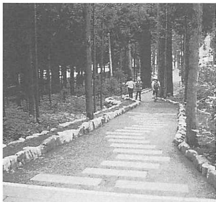
木質舗装を使った遊歩道（神奈川県）
