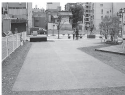
◀左 e : 舗設完了 (全景その1) ◀右 f : 舗設完了 (全景その2)
