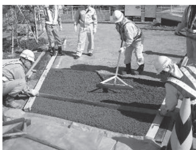
◀左 a : 型枠設置及び区分け状況 ◀右 b : 舗装材料の敷均し状況
