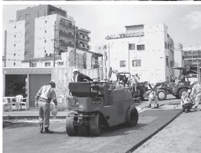
◀左 c : 一次転圧 (鉄輪ローラ) ◀右 d : 二次転圧 (タイヤローラ)
